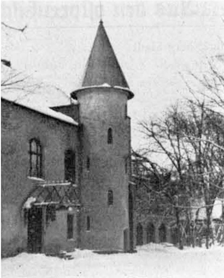
Rundturm am Eingang zum Herrenhaus
